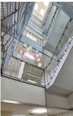
会館地下1階から4階まで設置
