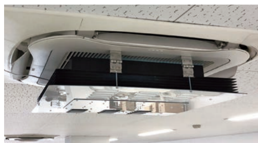
天井カセットエアコンへの設置例
