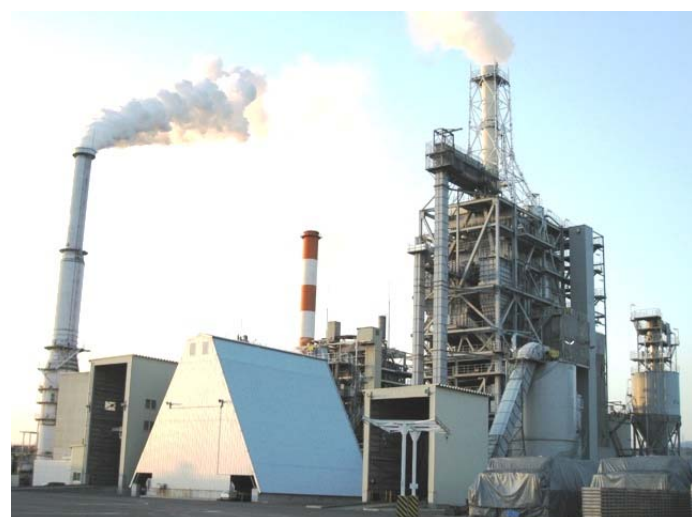
バイオマスボイラー
